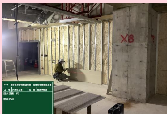
内外装工事 1階 ボード張付け状況
