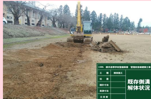
解体工事 既存側溝解体状況
