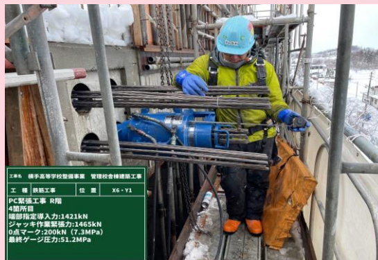
鉄筋工事 R階 PC緊張状況
