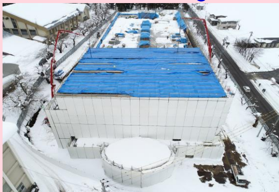
ドローンによる上空からの撮影 屋上階
