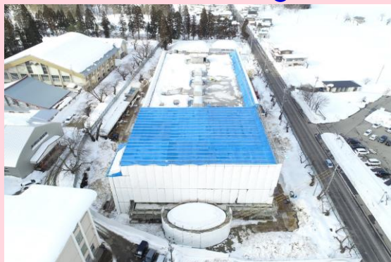
ドローンによる上空からの撮影 屋上階
