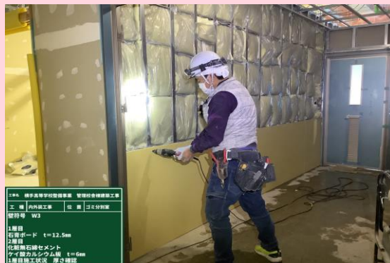
内外装工事 1階 石膏ボード取付状況
