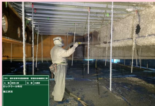
鉄骨工事 ロックウール吹付状況
