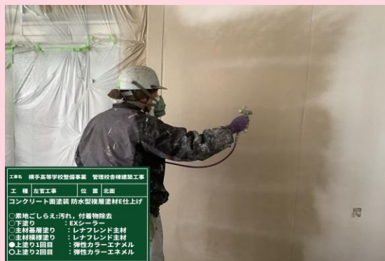
塗装工事 外壁吹付け状況
