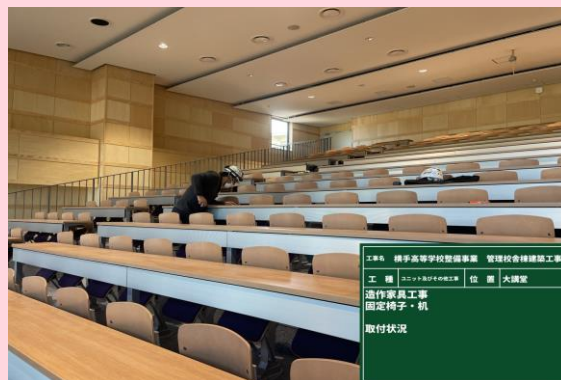
ユニット及びその他工事 造作家具工事 固定椅子・机 取付状況
