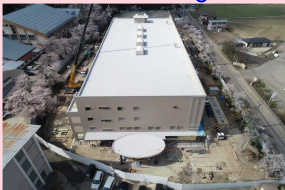
ドローンによる上空からの撮影
