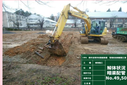
解体工事 既存暗渠配管解体状況
