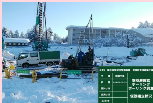
地業工事 ボーリング調査
