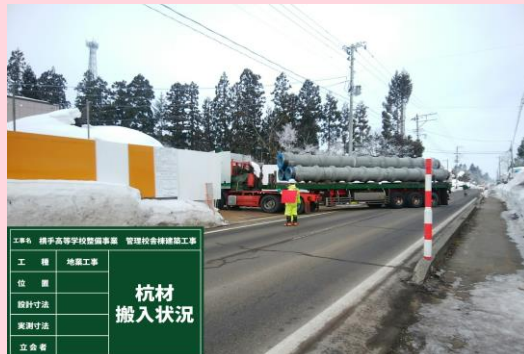
地業工事 杭材搬入状況
