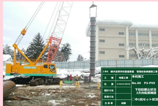
地業工事 本杭施工
