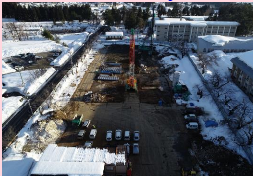
ドローンによる上空からの撮影
