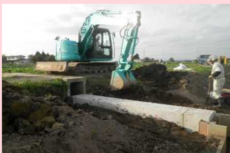
排水路工【排水路設置&埋戻し】
