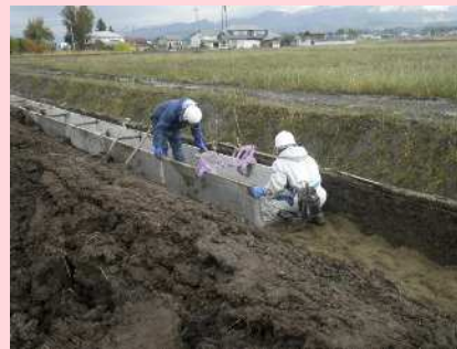
用水路工〔用水路 布設〕
