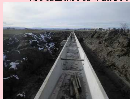
用水路工(用水路 布設完了)
