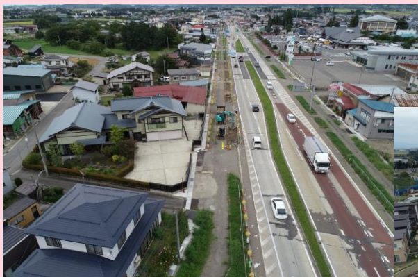
UAV 空撮状況
