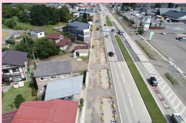
UAV 空撮状況
