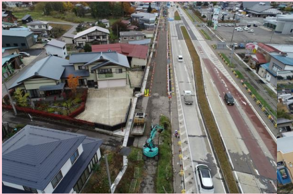
UAV 空撮状況
