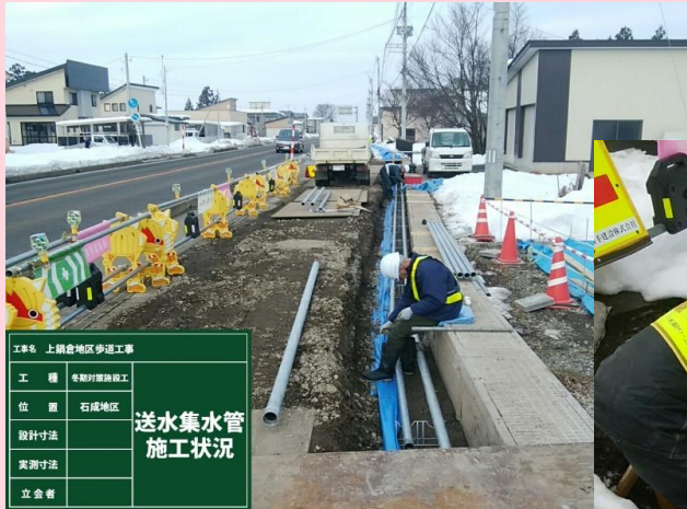
送水・集水管 施工状況
