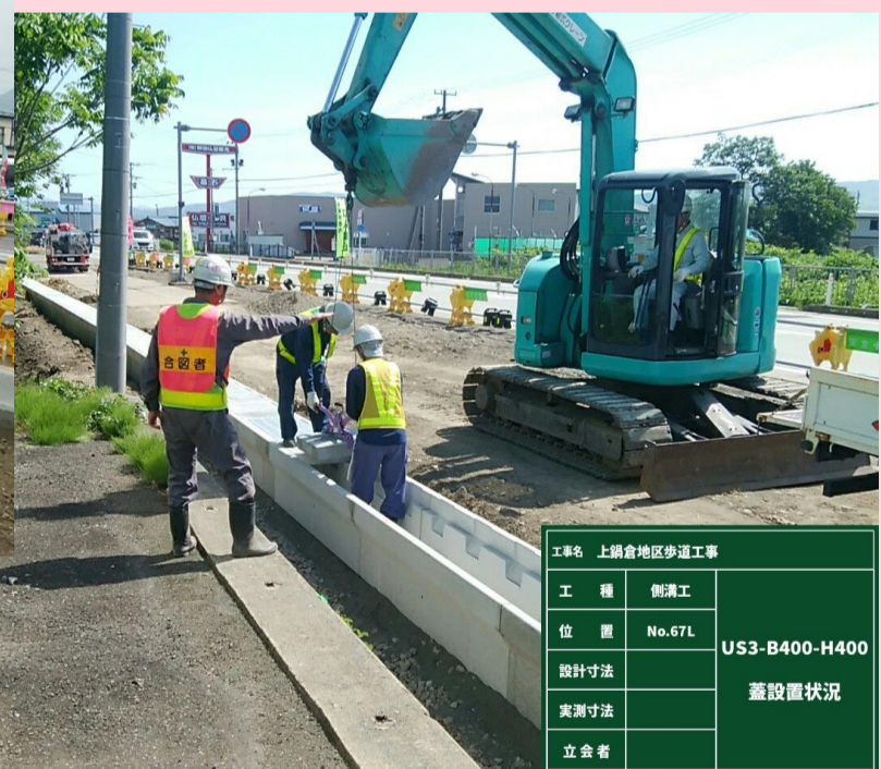
側溝 据付状況
