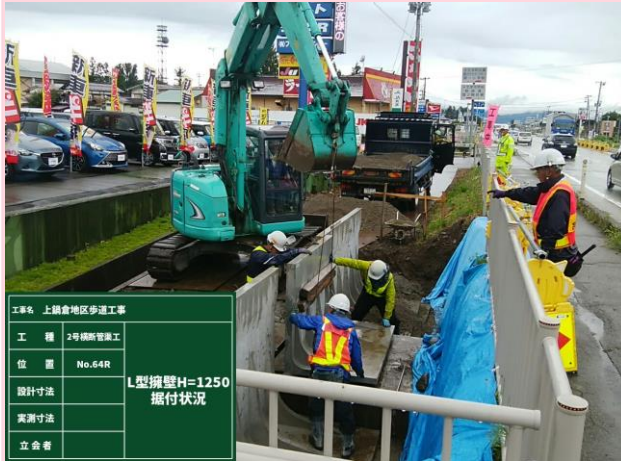
L型擁壁 据付状況
