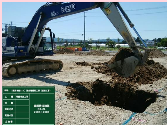
地盤改良工事
