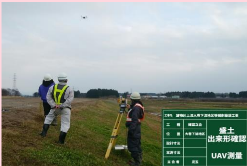
👉 大巻盛土UAV測量
