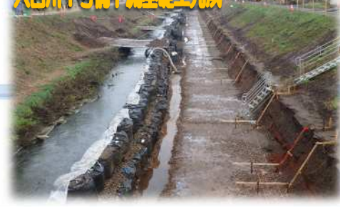
大宮川1号橋下流基礎工完成
