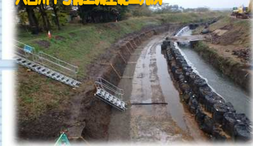
大宮川1号橋上流基礎工完成
