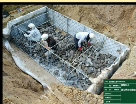
4号床固工 詰石状況
