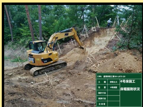
4号床固工 掘削状況
