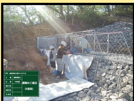
4号床固工 鋼製カゴ組立状況
