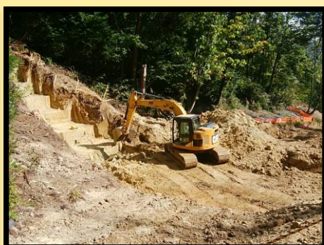
6号床固工 床掘削状況
