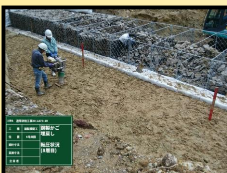
6号床固工 埋戻し状況
