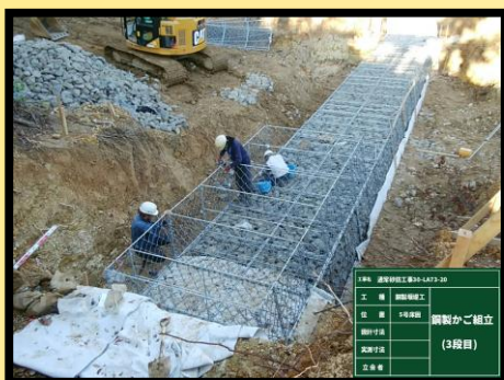
5号床固工 鋼製かご組立
