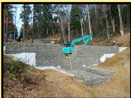
5号床固工 完成
