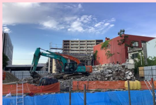
旧第一生命ビル 上屋解体状況
