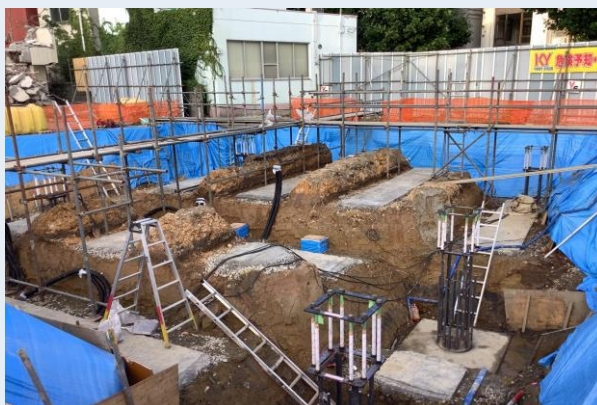
郵便局 地足場組立状況
