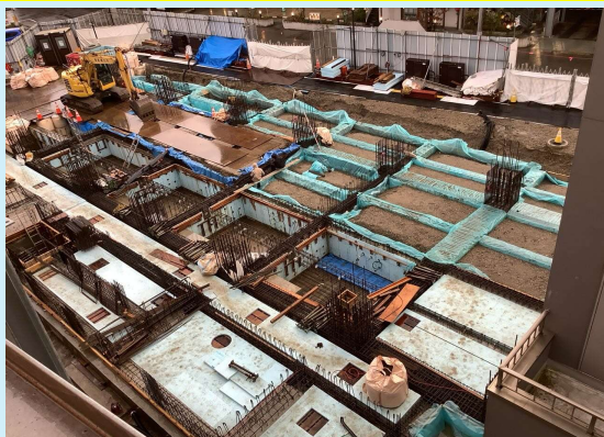
C-2棟 基礎工事状況
