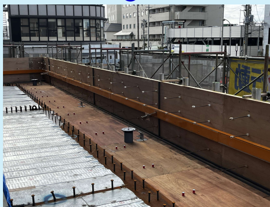
B-1棟歩廊 型枠組立状況
