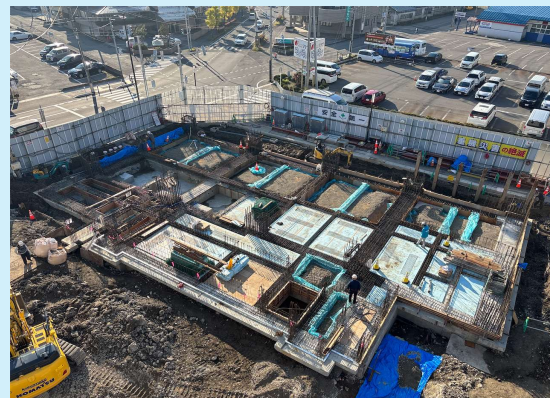
D棟 基礎工事状況
