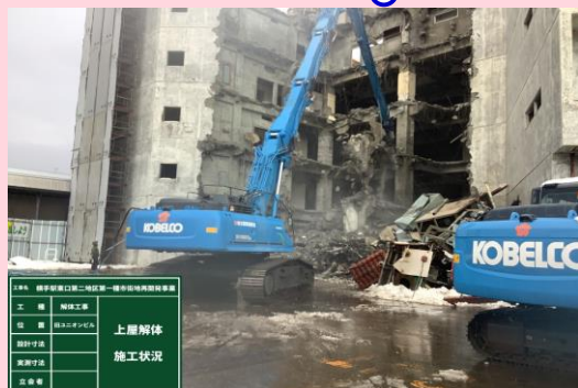
旧ユニオンビル 上屋解体
