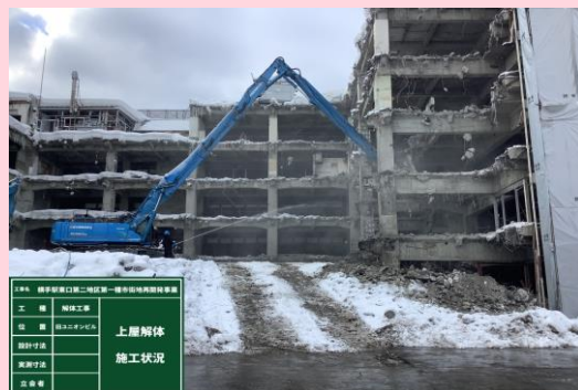
旧ユニオンビル 上屋解体
