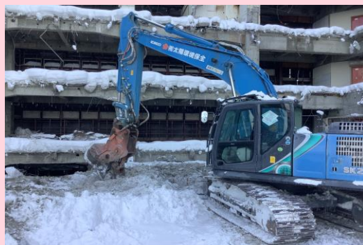
旧ユニオンビル 解体材小割
