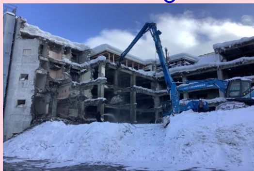
旧ユニオンビル 上屋解体
