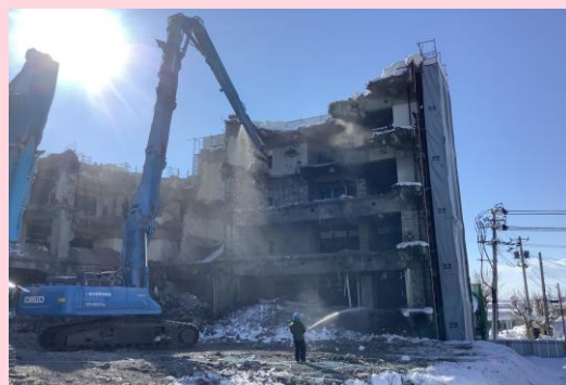
旧ユニオンビル 上屋解体
