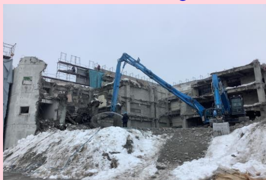
旧ユニオンビル 上屋解体
