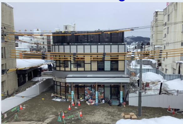
C-1棟 全景(西側より撮影)
