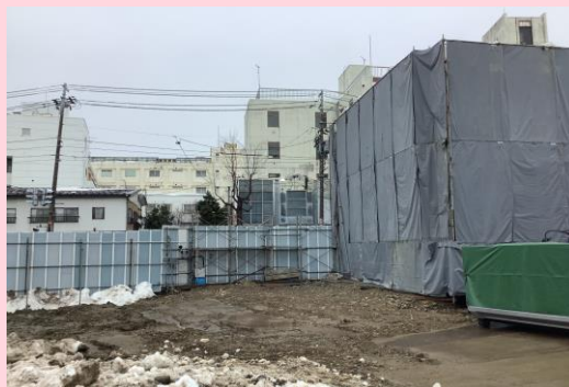
旧すえひろ車庫 解体完了
