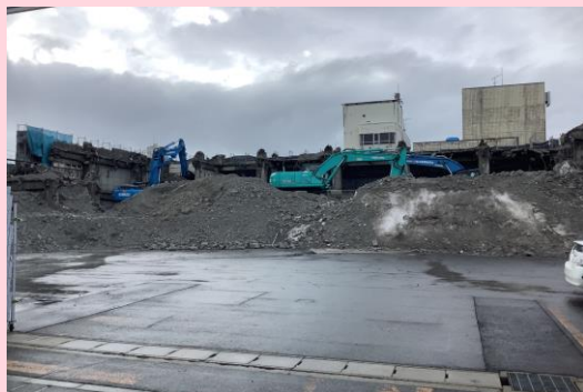
旧ユニオンビル 解体材搬出
