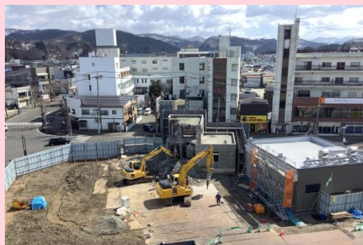
横手駅前郵便局 上屋解体
