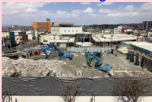
旧ユニオンビル 解体材搬出
