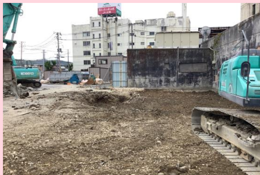
いずみビル 基礎解体状況
