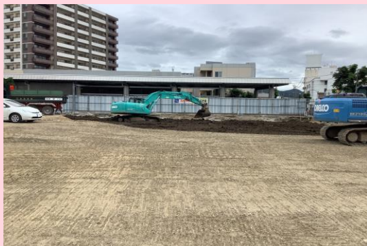
ユニオンビル 埋戻し状況
