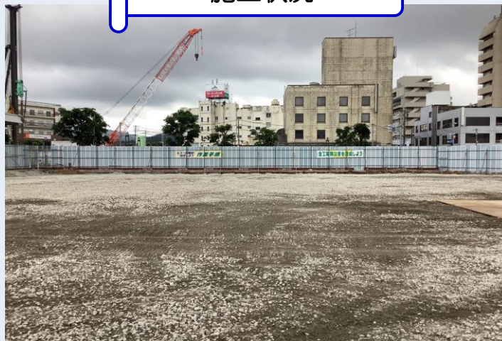
A棟 着工前
