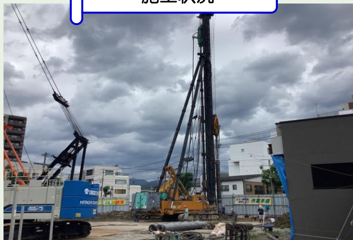
B-1棟 本杭打設
