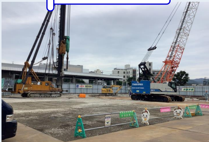
A棟 杭打機組立完了
