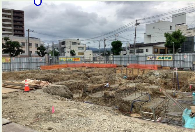
B-1棟 根切り・捨てコンクリート枠設置
