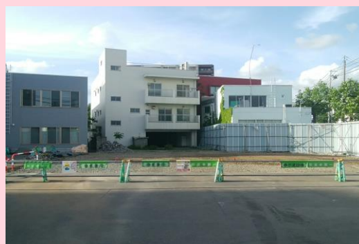
解体工事 大澤宅解体完了
