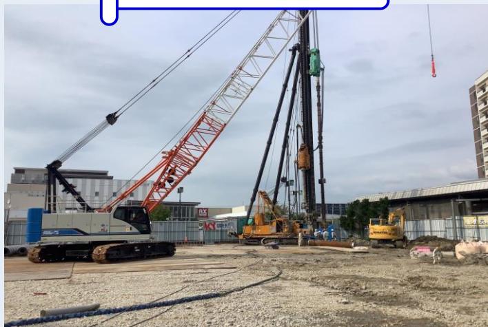
A棟 本杭打設状況
