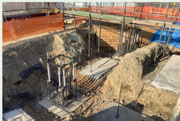
B-1棟 基礎配筋
