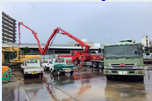
3工区 捨てコンクリート状況
