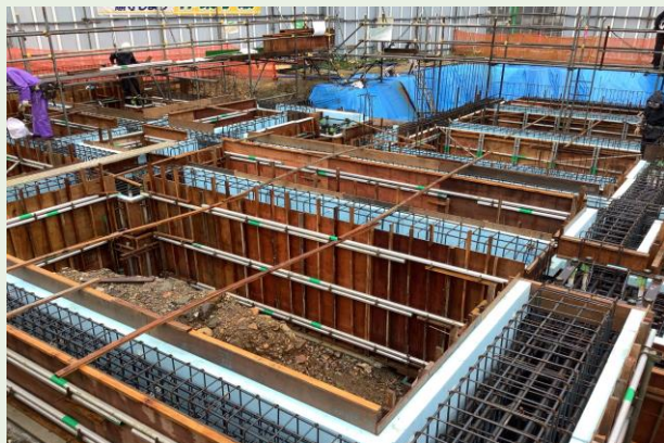
1工区 基礎配筋・型枠状況
