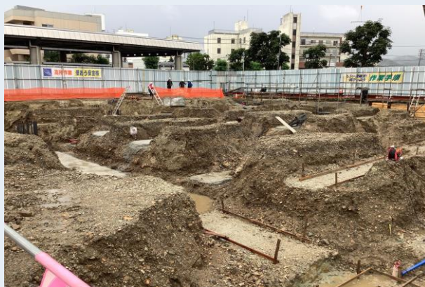
2、3工区 根切り捨てコン砕状況
