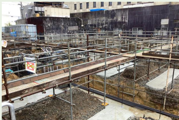
3工区 地足場組立状況
