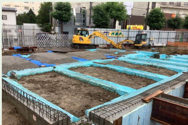
1工区 埋戻し状況
