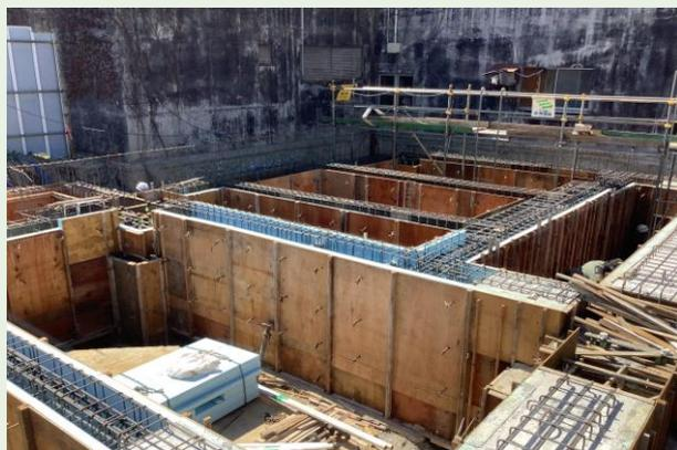
2-2工区 基礎型枠建込み状況
