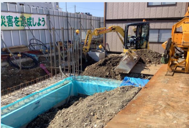
2工区 ハンドホール設置状況
