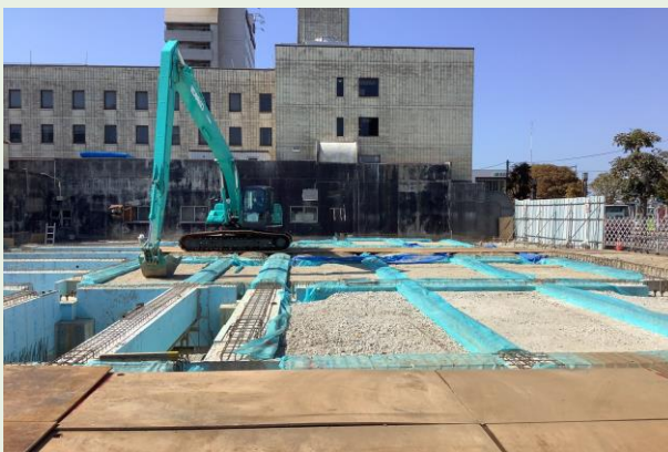
2～3工区 埋戻し完了
