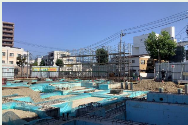
1工区 外部足場組立状況
