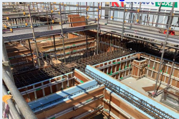
4工区 基礎型枠建込み状況
