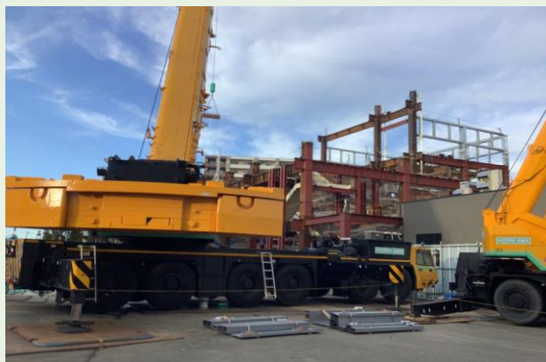
A・B工区 鉄骨建方状況
