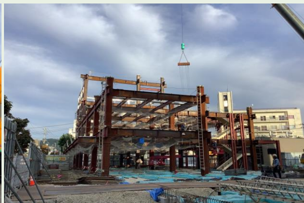
A・B工区 鉄骨建方状況
