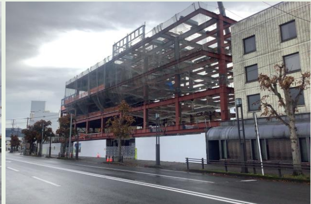
D工区 鉄骨建方状況
