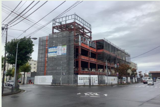
外部足場組立状況
