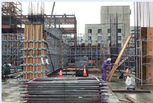
1工区 柱型枠建込み状況
