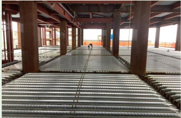
4階 インサート打ち込み状況
