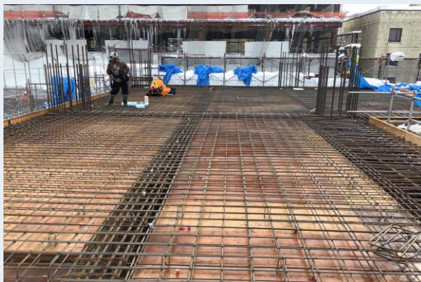
2階スラブ配筋状況
