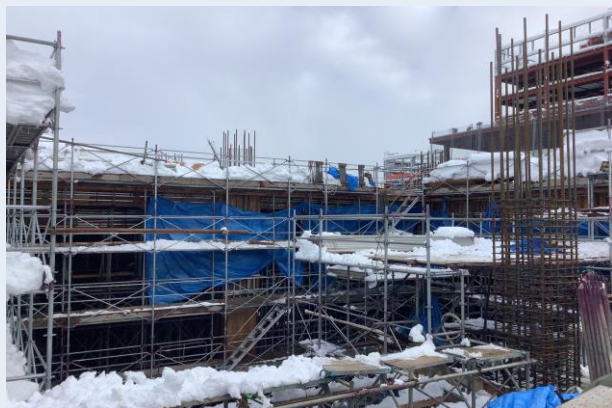
2階躯体型枠建込み状況
