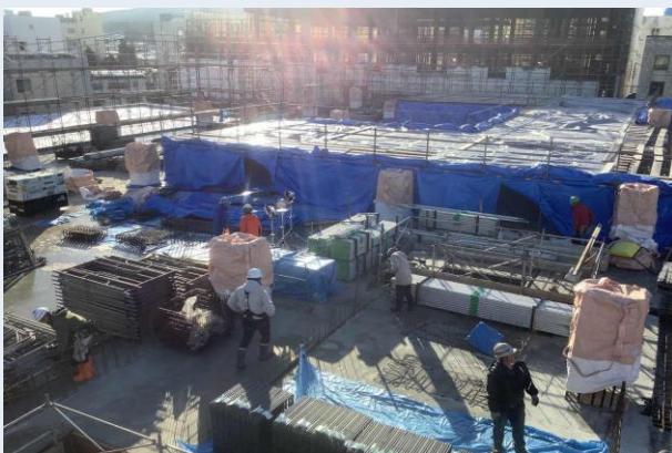
2階躯体配筋・型枠建込み状況
