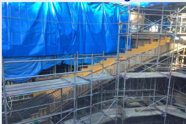
2階躯体配筋・型枠建込み状況
