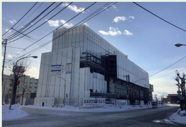
外部足場・構台組立状況
