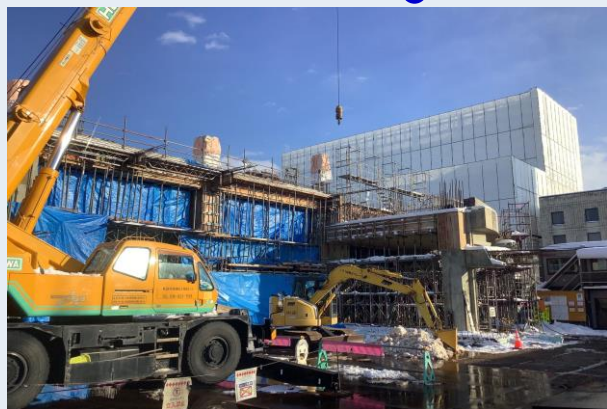
西面外部足場一部解体完了
