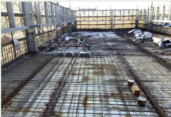
R階 スラブ配筋状況
