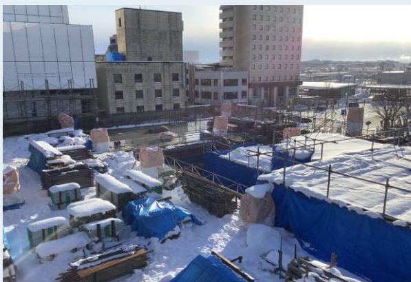
2階躯体コンクリート打設完了
